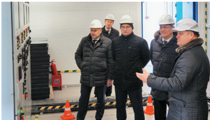
Радий Хабиров, Глава Республики Башкортостан, и Сергей Гурин, председатель правления – генеральный директор АО «БЭСК», дают старт пусконаладочным работам на строящейся подстанции 110 кВ «Осоргино» в Уфимском районе региона, 5 марта 2024 г.
