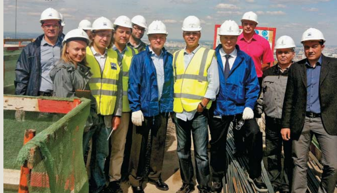
На строительстве башни «Федерация» в МДЦ «Москва-Сити»
