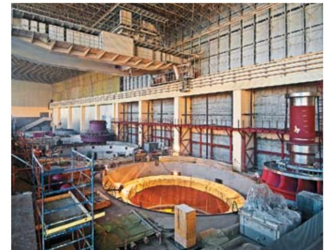
Саяно-Шушенская ГЭС. Комплекс строительно-монтажных работ по восстановлению машинного зала, реконструкции ОРУ 500кВ со строительством КРУЭ-500кВ
