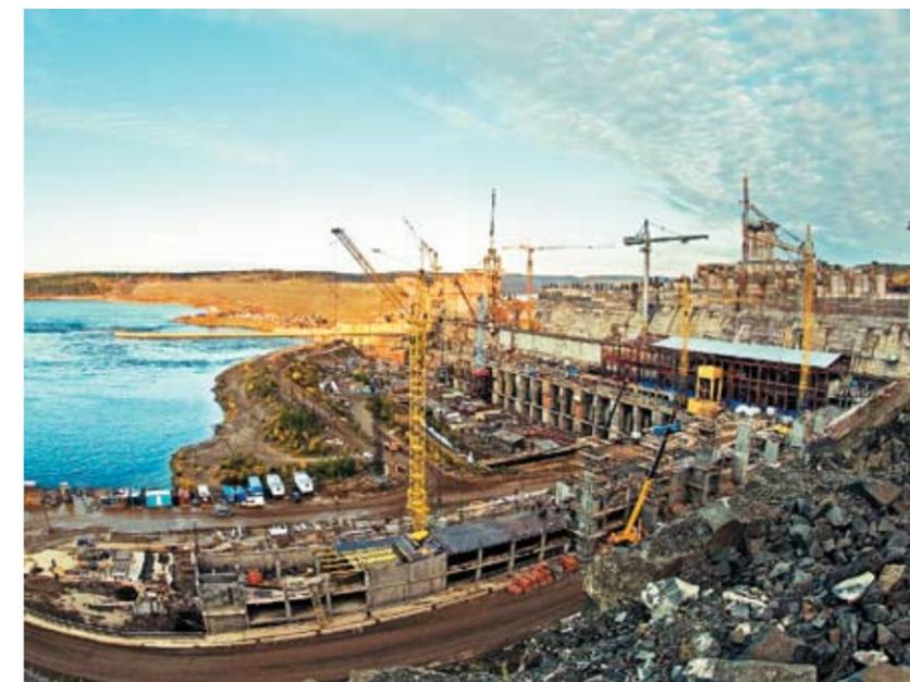
Богучанская ГЭС. Комплекс строительно-монтажных работ по возведению бетонной плотины и каменно-набросной плотины
